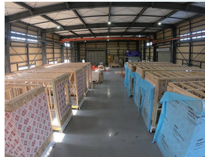
モジュール住宅建設工場
