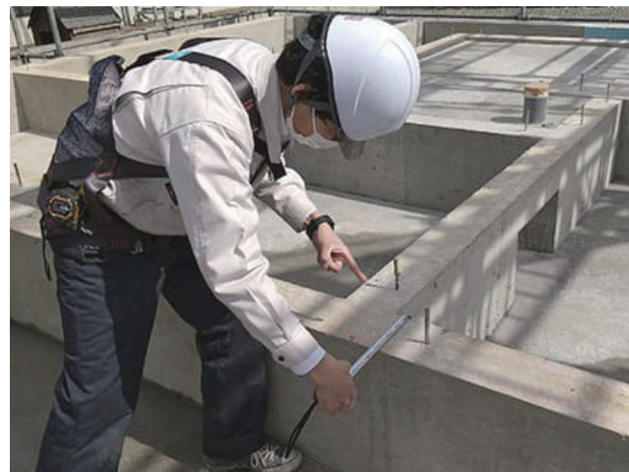
現場での検査の様子
